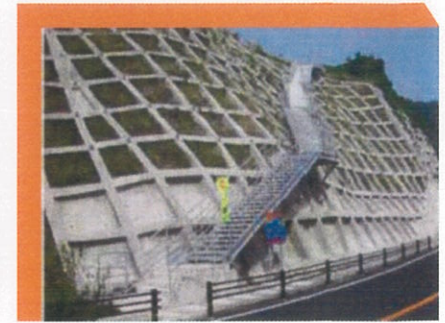
■避難路(イメージ) 災害公営住宅居住者や周辺の居住者・就業者・観光客等が、高台に避難するための避難路
