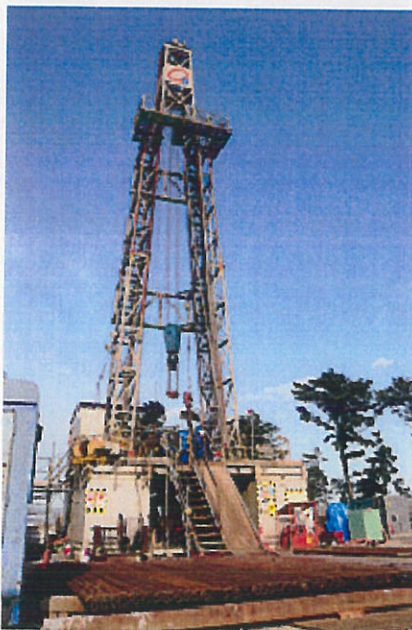
↑ 【H29年11月 温泉掘削工事現場】
